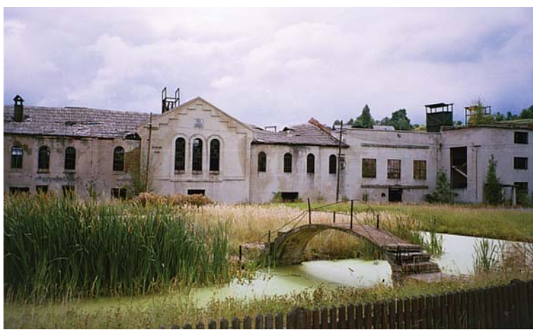
Stare budynki salinarne w Kaczycy
