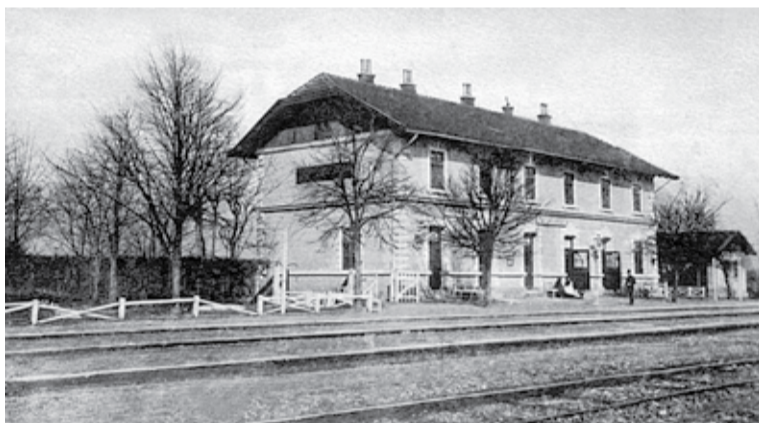
Tak wyglądała stacja w Tyśmienicy w 1916 roku
