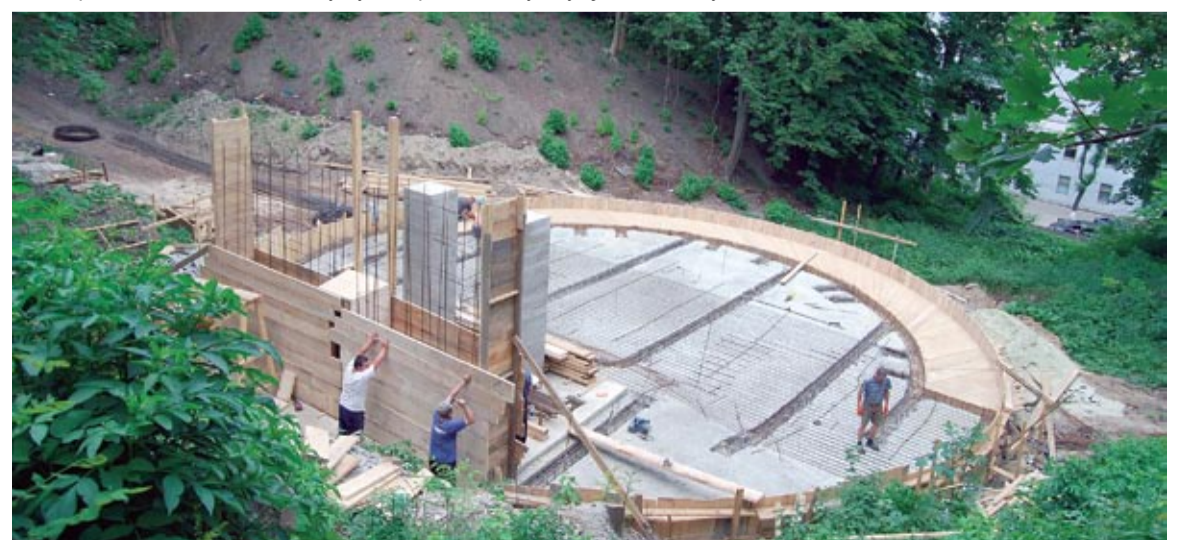
Budowa nowego pomnika
